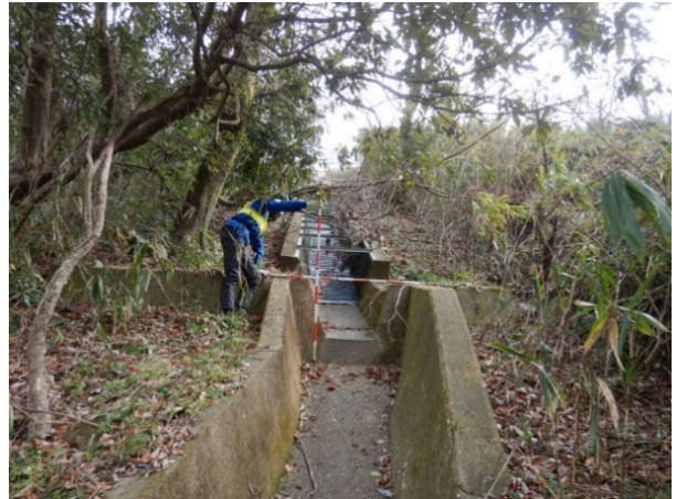
写真⑳ 終点側縦排水路 幅 1m、深さ 0.6m
