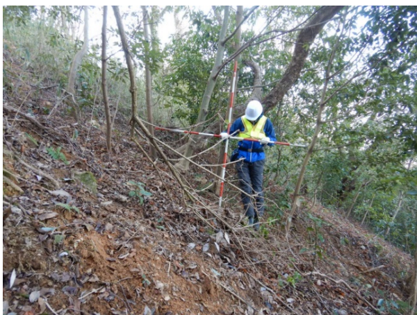
写真⑰ 崩土の最長到達部付近
