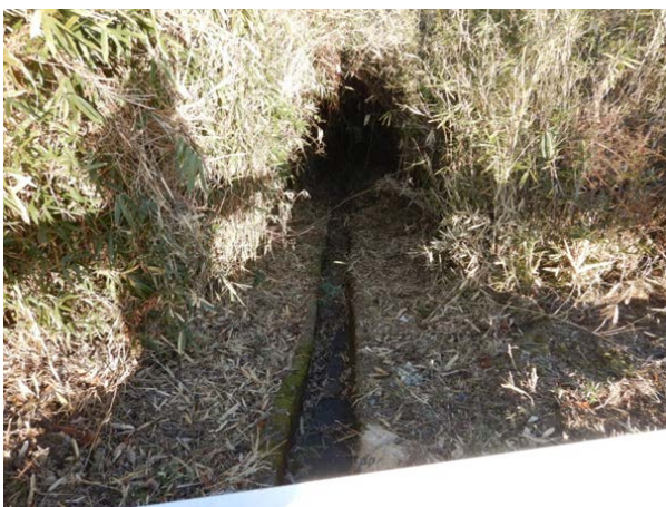
写真④ 終点側縦排水路幅 1m、深さ 0.6m
