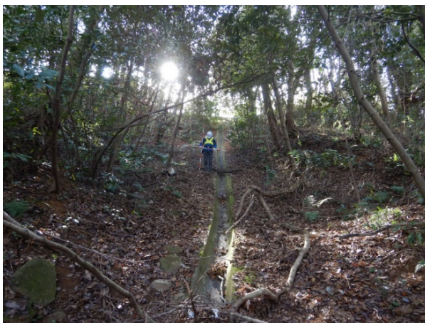
写真⑧ 距離標 No. 224+5m 付近 縦排水路、幅 0.4m、深さ 0.2m
