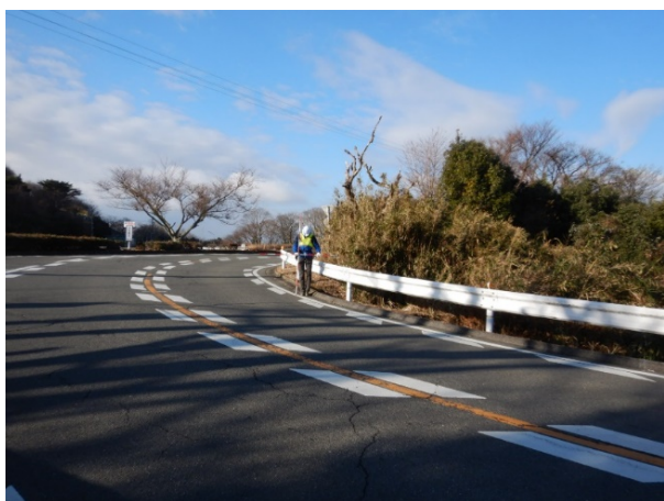
写真① 起点側
