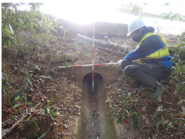
写真⑨ 距離標 No. 224+5m 付近 暗渠吐口、径 0.4m
