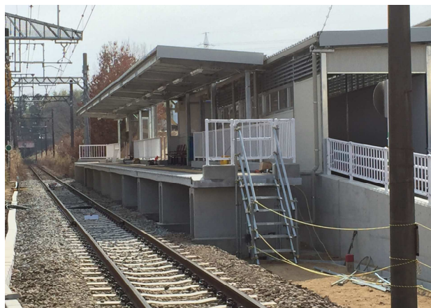
写真-1 完成後の状況
