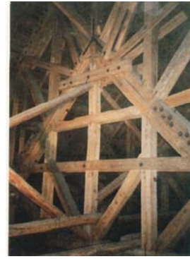
写真-3 天井内トラス架構
