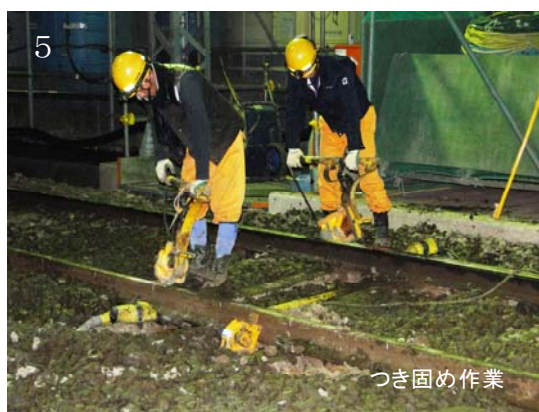
写Ⅱ-3-4 沈下計の撤去・復旧作業状況
