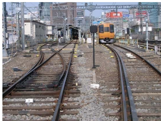
米野車庫線（片側1箇所）
