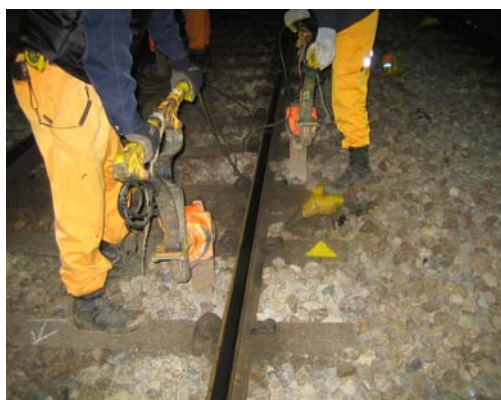
写Ⅱ-3-3 軌道整備の状況
