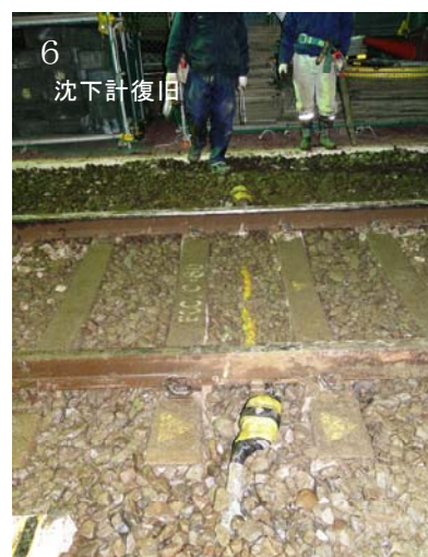
写Ⅱ-3-4 沈下計の撤去・復旧作業状況
