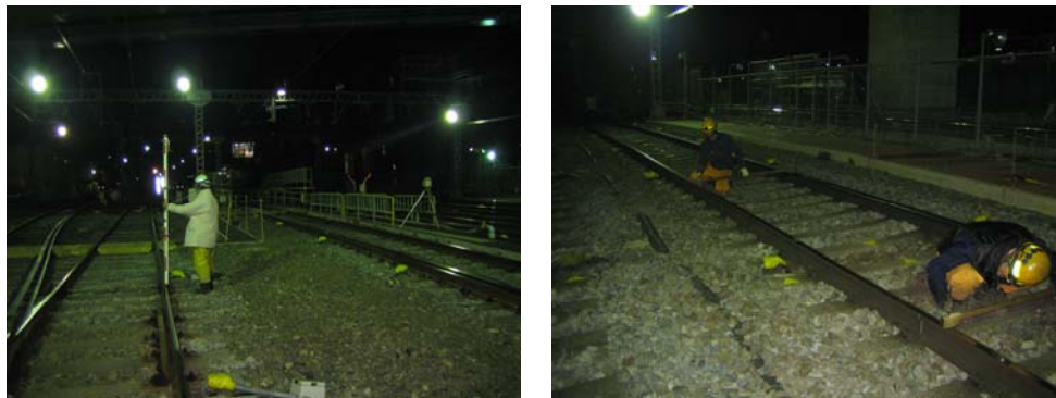
写IV-3-1 軌道検査状況
