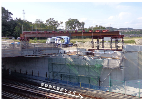
写真-1 右側張出部 吊り型枠設置状況
