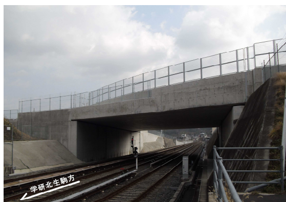
写真-2 完成後の状況
